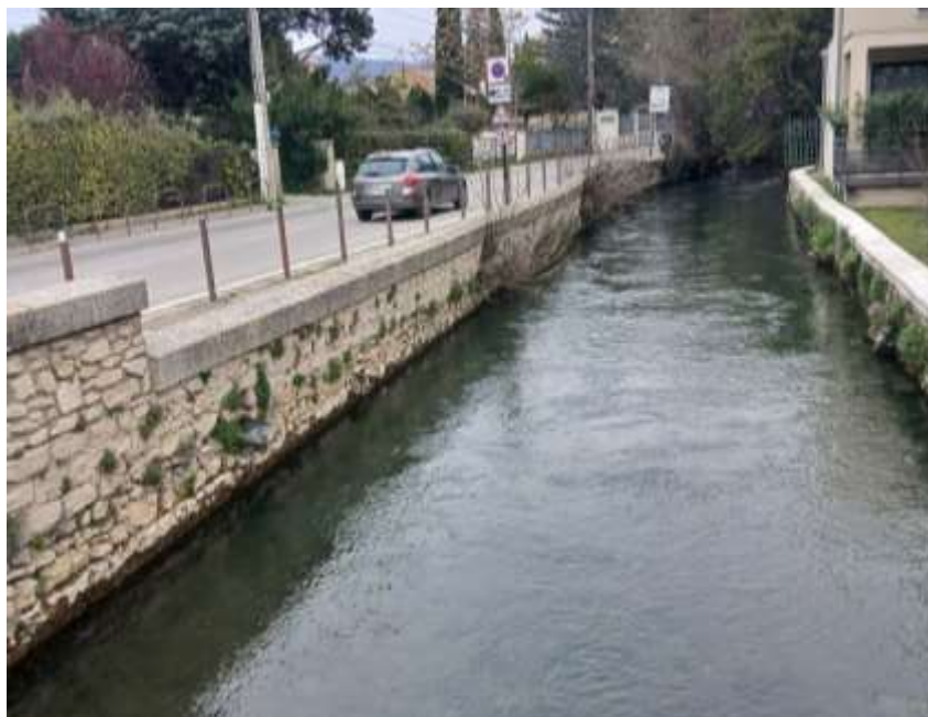
Vue depuis l'aval
